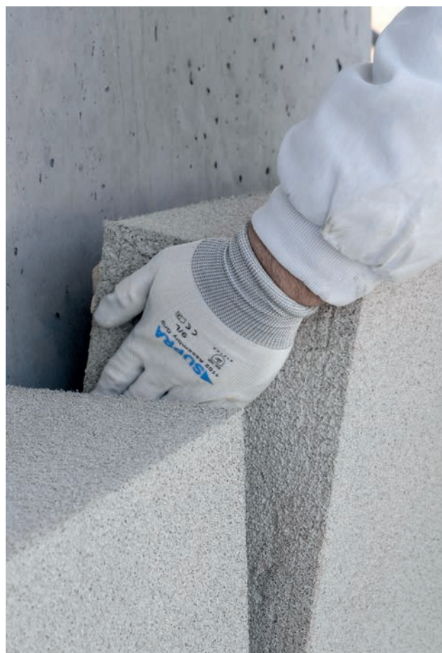
Application de l'isolation de façade avec swissporECORIT.
